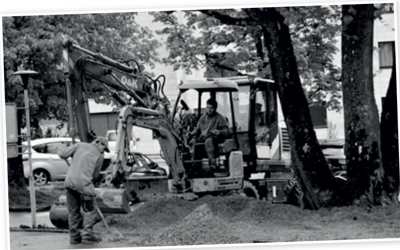
Präzisionsarbeit von Dani Muff mit dem Bagger: Rasen abschälen und nährstoffarmen Schotter auf dem Kirchgelände einbringen.
