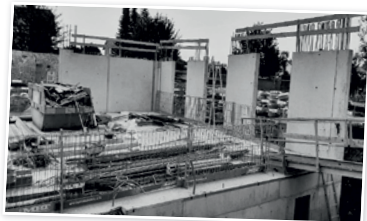
Betonieren Boden EG
