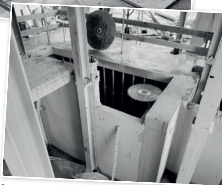
Fräsarbeiten an der alten Luftschutzdecke
